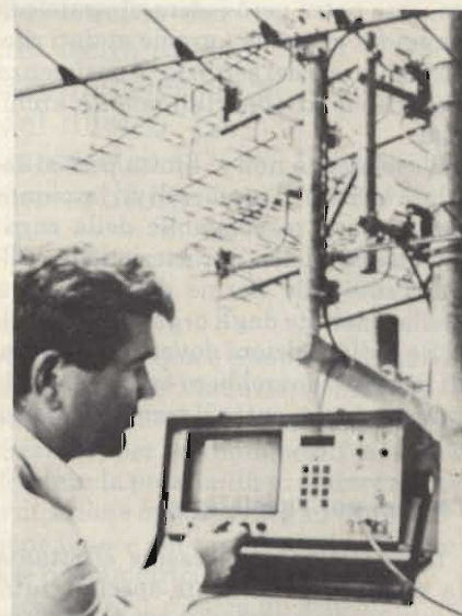
Fig. 3 - Gli strumenti di misura impiegati per il servizio di assistenza consentono di determinare con precisione i livelli nominali dei segnali.
